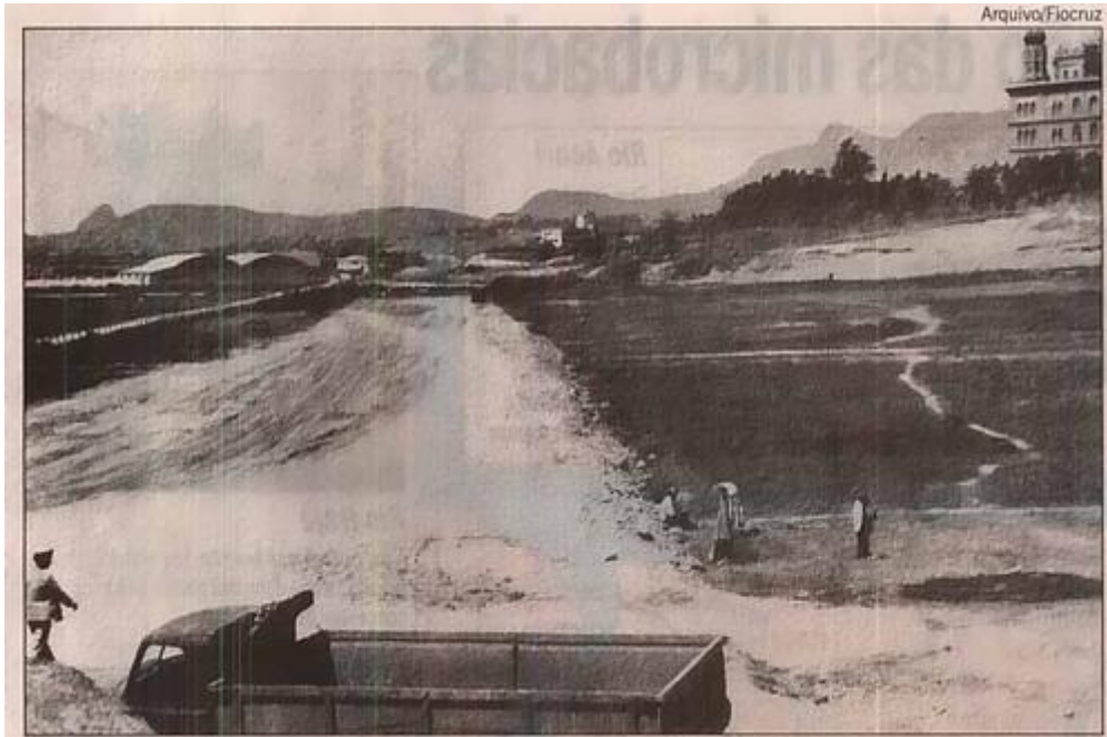
Construção da Avenida Brasil
