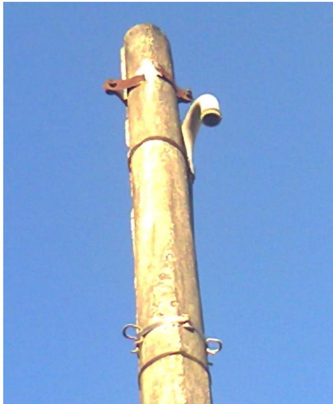
**Foto 8:** *“A: Isso a gente não faz, o ramal do poste está arrancado. Serviço que não realizamos, o poste do cliente está sem a roldana, é impossível calçar o ramal sem a roldana. Este poste também estava rachado. É o risco que não podemos correr, subir no poste rachado. Neste dia nós não mexemos neste poste.”*
