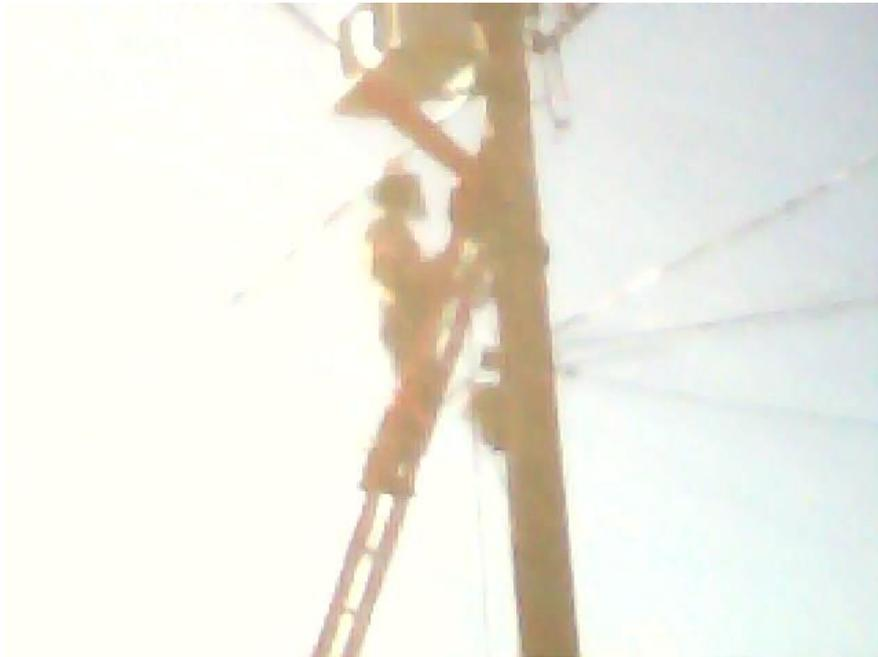
**Foto 2:** *“A: Esse é o meu parceiro de trabalho. Tirei essa foto porque ele está bem embaixo do transformador, cortando a luz no poste. Nesse caso é um risco a mais que a gente corre, porque passa alta tensão em cima. O certo é colocar a escada no outro lado, mas não conseguimos quase nunca, pois no outro lado tem fios de energia elétrica também, que impedem o acesso.”*
