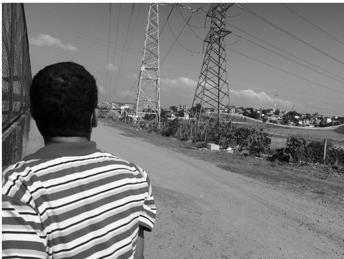
FIGURA 30- vista de Cariacica com torres de alta tensão. 2017. Fotografia digital.
